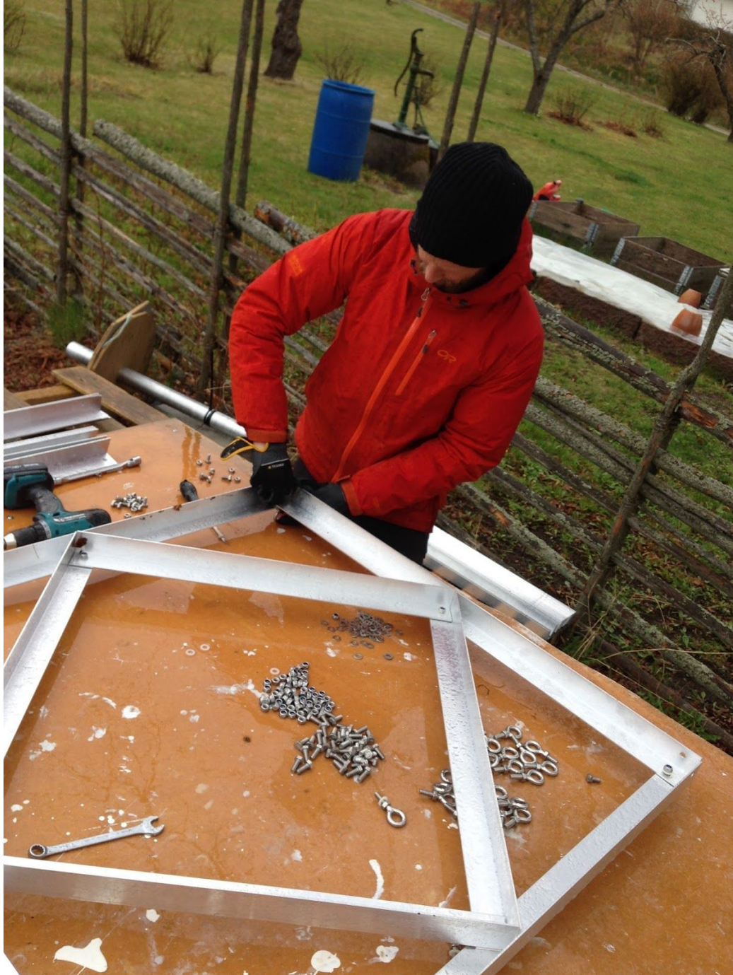
Foto 9. Tillverkning av testriggar "burrigar"
